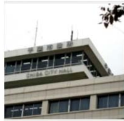
千葉市役所（建て替え工事中、2020年11月6日撮影）
